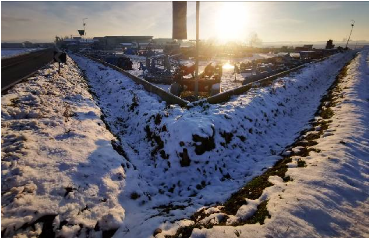
Vista da spigolo NE verso l'interno dell'area
