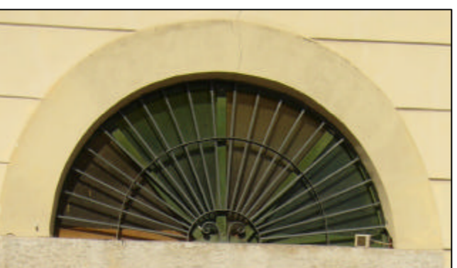
Sopraluce ad arco a tutto sesto con rostra a disposizione radiale
