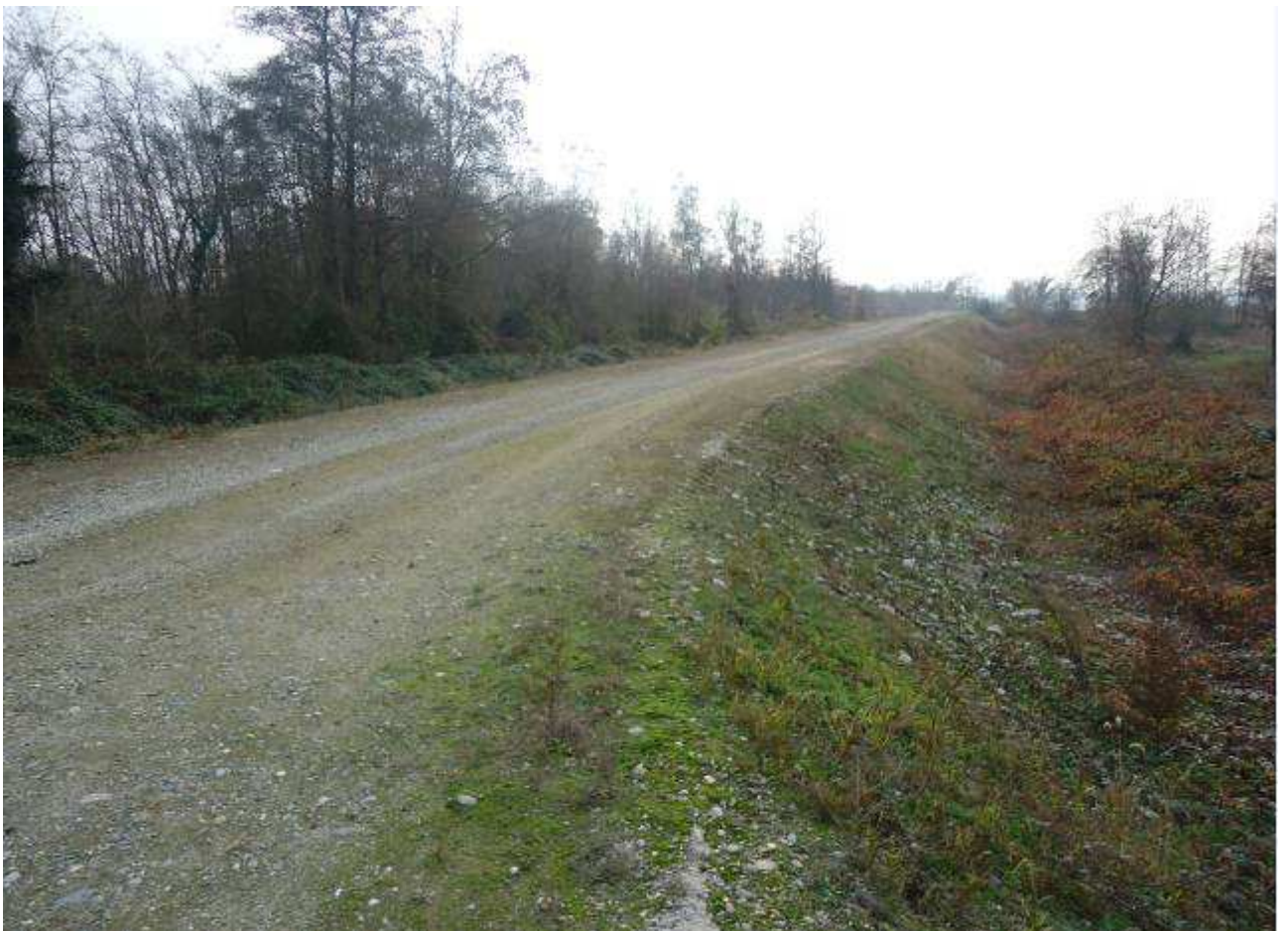
Tratto A (verso NORD)
