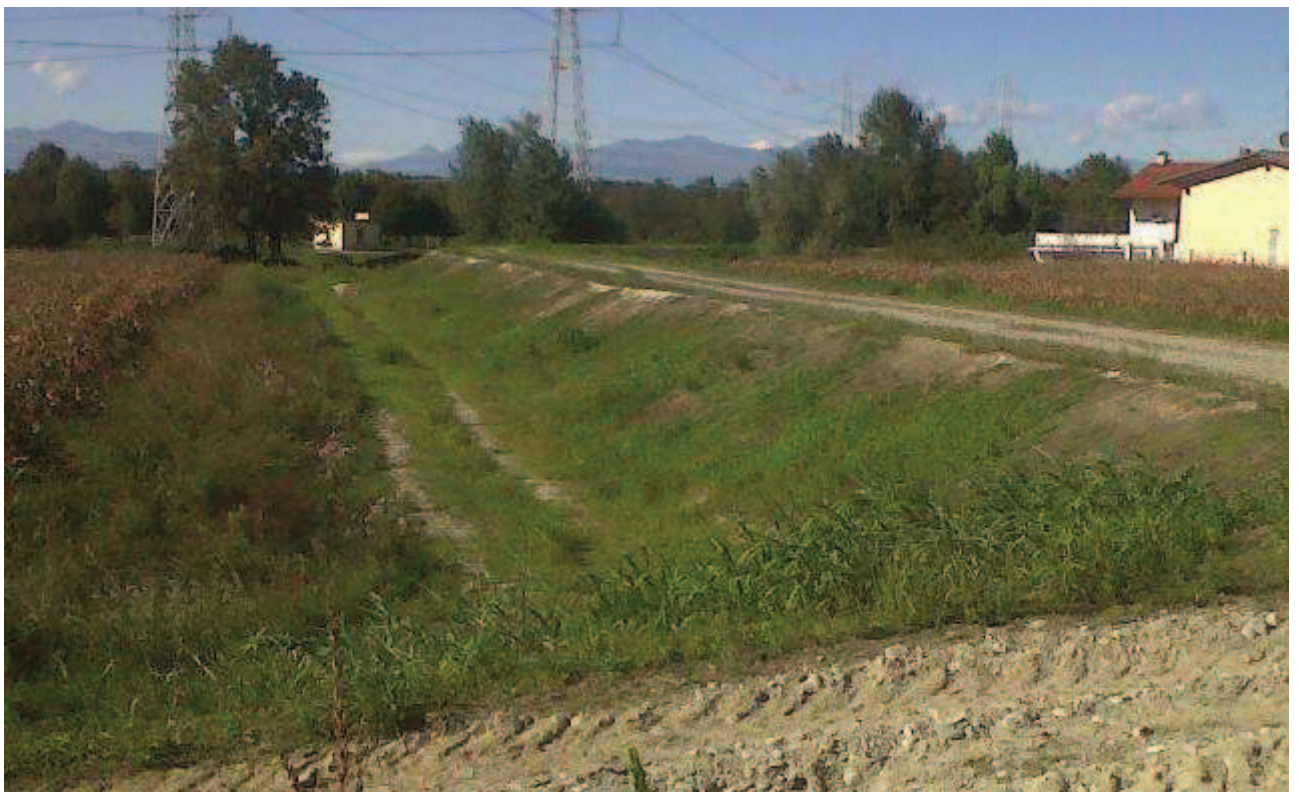
Tratto a Ovest di C.na Muggetta (verso nord)
