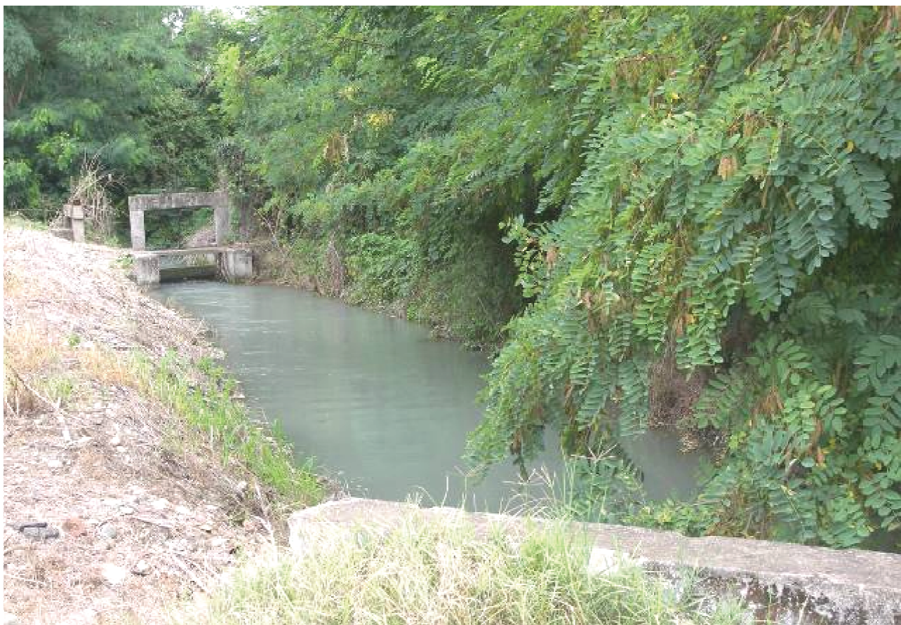
Roggia delle Vigne – ripresa dallo spigolo Nord/Est dello stabilimento
